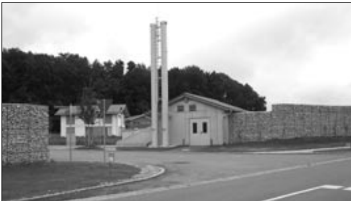
Zu den Aufgaben der neugegründeten „Geweg“ gehört auch das Heizkraftwerk Wetterling. Foto: cg
