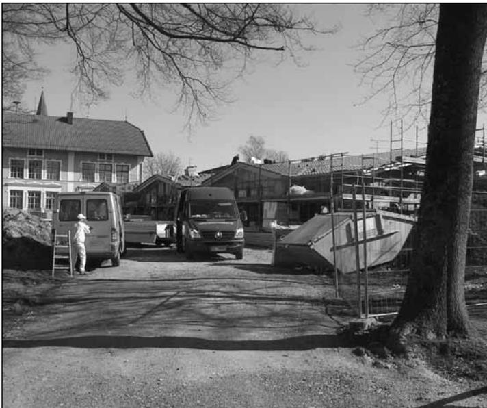
Der Bau des gemeindlichen Kindergartens am Klosterweg ist im Zeitplan. Unter der Leitung des Generalunternehmers, der Firma Säbu aus Biesenhofen, arbeiten die Gewerke Dachdecker, Heizung/Sanitär/Wasser, Trockenbau und Elektro auf Hochtouren, damit der Estrich eingebracht werden kann und dann Fliesenleger, Maler und Bodenleger ihre Arbeit aufnehmen können. Die Endabnahme für den Bau ist noch vor Pfingsten terminiert.
