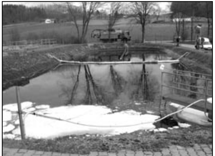
Ursache gefunden, Schaden beseitigt. Dazu waren von Seiten der Feuerwehr 45 und vom Bauhof 67 Arbeitsstunden nötig. Foto: Otterbein
